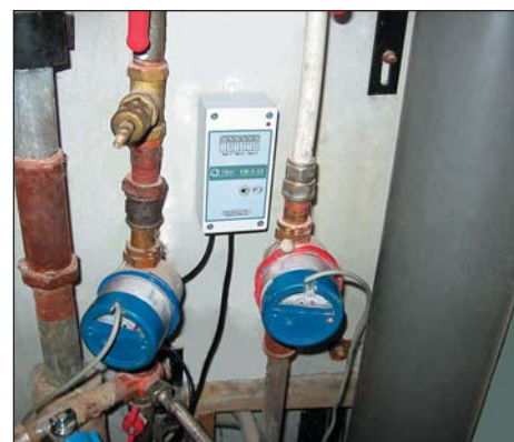
Рис. 7. Установка квартирного контроллера КМ-К-3Z
